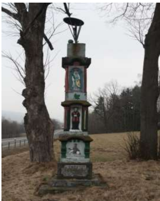
Kapliczka w Podłopieniu, stan przed remontem
